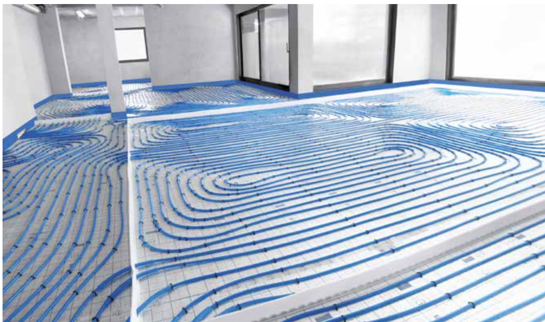
Slika 25. KAN-therm Tacker sistem podnog grejanja/hlađenja.
