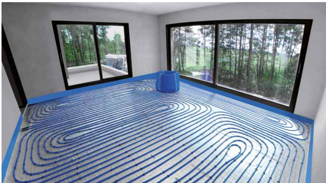
Slika 3. Instalacija podnog grejanja u jednoj porodičnoj zgradi, korišćenjem blueFLOOR PERT cevi i KAN-therm Tacker sistema.
