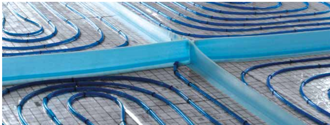
Slika 14. Raspored grejnih polja sa dilatacionim pregradama
