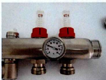
Nalijegajući termometar montiran na razdjelniku
