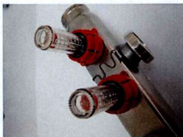
Opruga za pričvršćivanje termometra na razdjelniku
